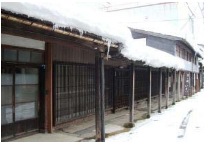
図 18 上越市街地でみられる「雁木」 (上越市ホームページより引用)
